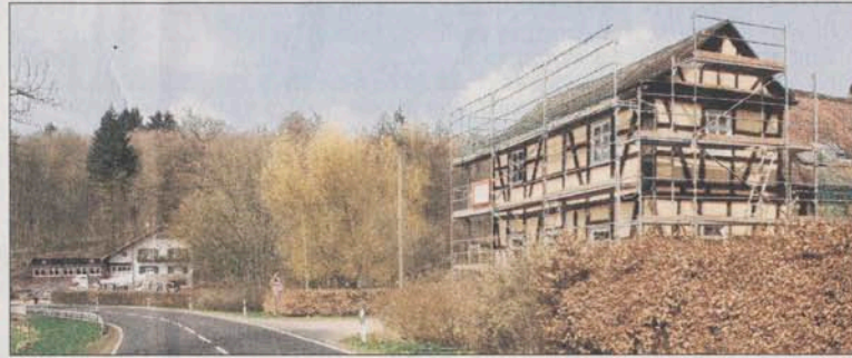
Das alte und neue Jägerhaus an der Straße nach Schotten sind Ausgangspunkte für den Laubacher Entdeckungswald »Grünes Meer«.
